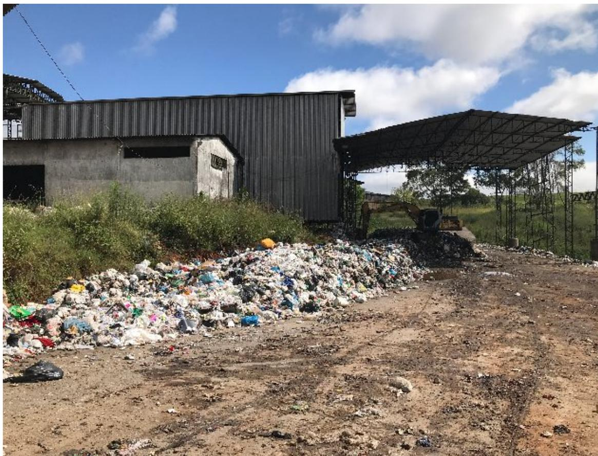
Rejeitos armazenados a céu aberto, fora do piso impermeabilizado.
